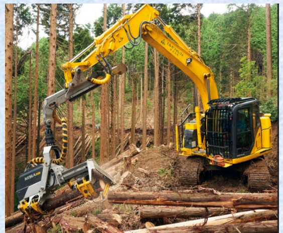
間伐(高性能林業機械)
